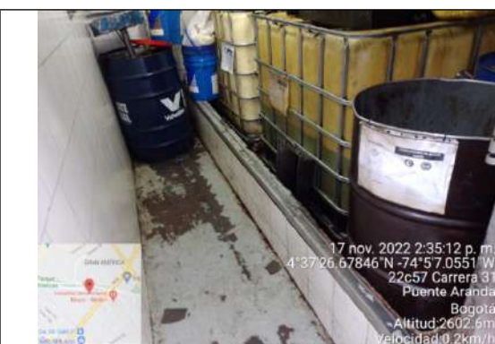
Fotografía 4. Dique de contención
